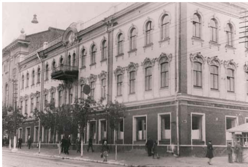
Учебный корпус № 2 на ул. М. Горького
